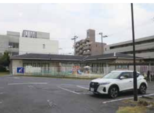
74. こすもす保育室 〔平成14年完成〕
