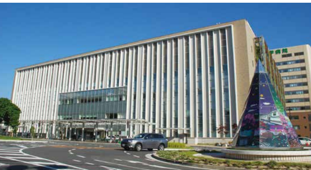
81. 診療棟〔平成25年完成〕 右は屋上庭園。
