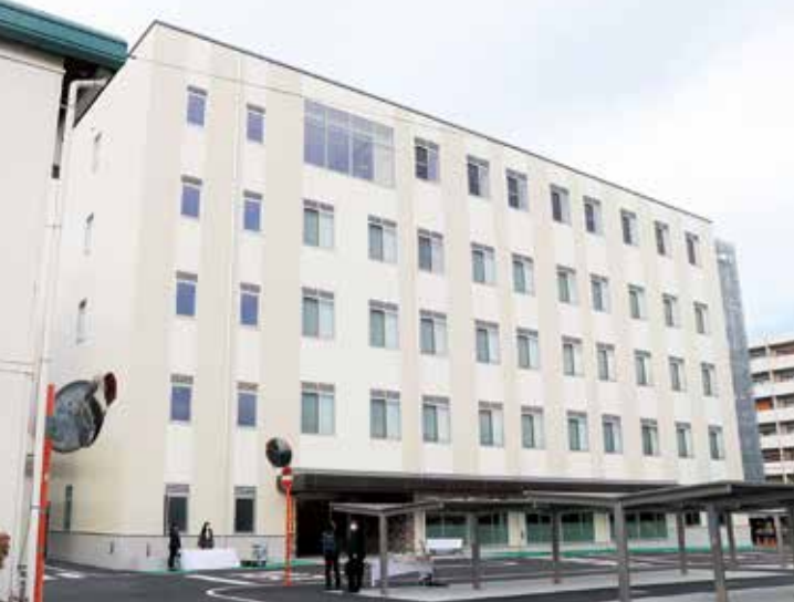
27. 凌雲棟(霞・東千田地区の学生のための教育棟)完成〔霞、令和4年11月〕
