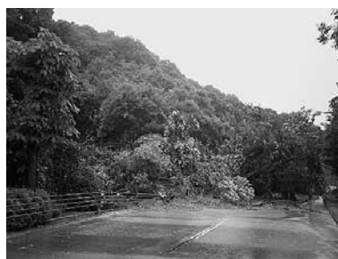
写真6-27 附属幼稚園裏山にて土砂崩れ発生、 プールバールに土砂が流出 (平成30年7月)
