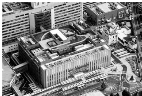
写真6-10 新診療棟（平成25年4月完成）
