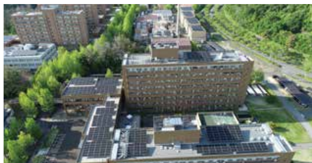
214. 設置されたソーラーパネル(生物生産学部、令和6年6月)
