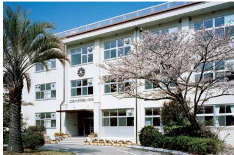
106. 附属小学校校舎〔翠、平成21年改修〕
