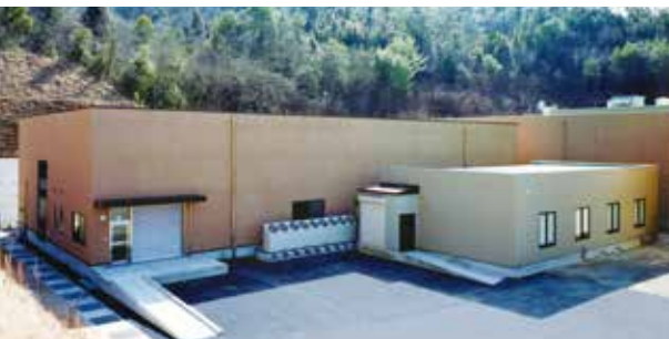
53. 放射光実験準備棟〔平成14年完成〕
