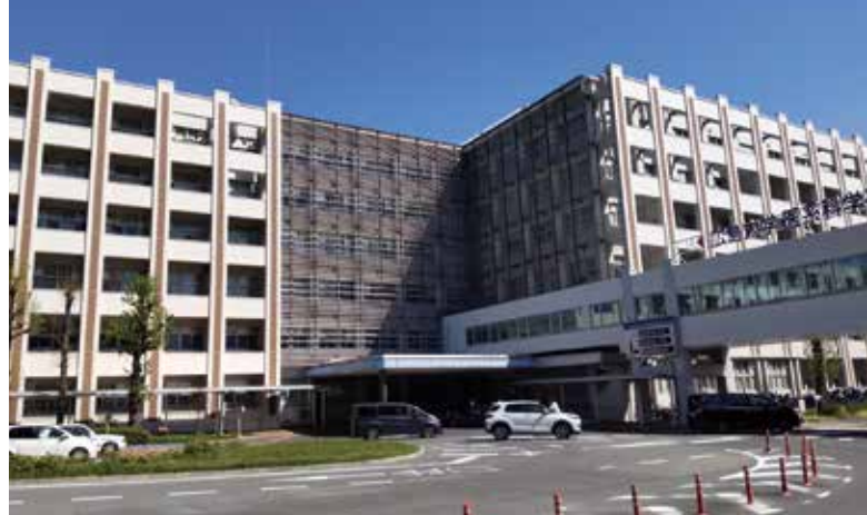
85. 研究棟A:歯学部〔令和2年改修〕
