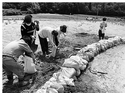
写真6-29 土砂の撤去作業を行う学生ボランティア（平成30年7月）
