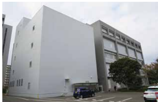
90. 動物実験棟増築棟 〔令和5年完成〕
