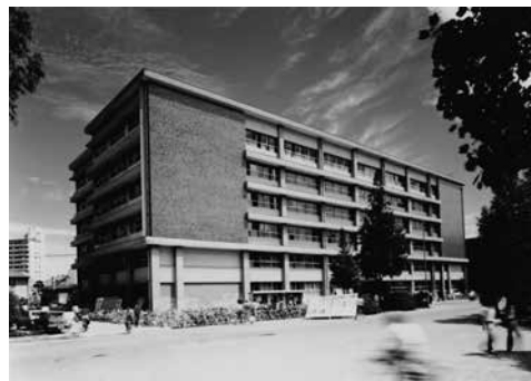
写真4-5 総合科学部校舎（東千田、昭和56年）
