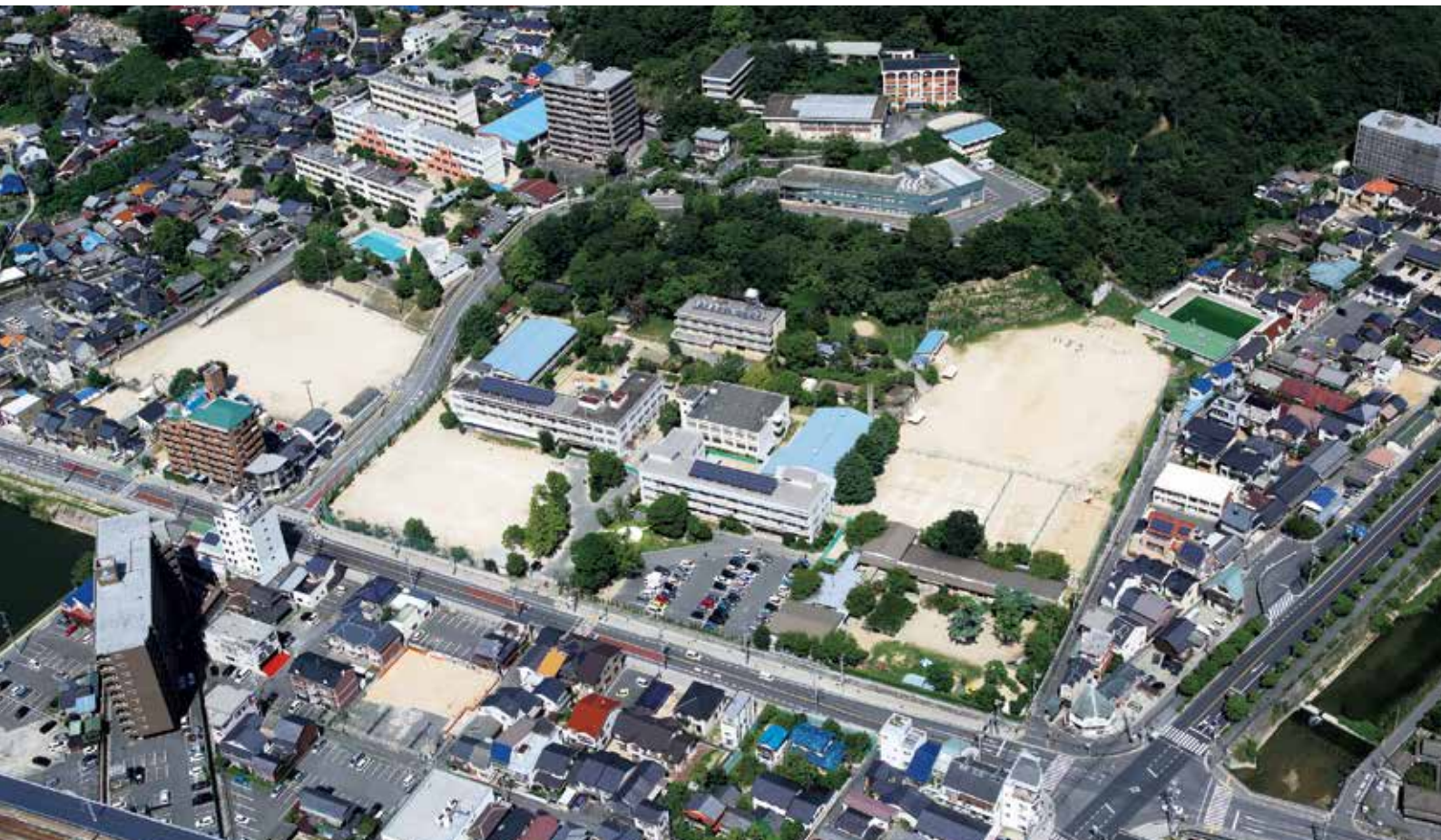
100. 三原地区(附属三原幼・小・中学校)航空写真〔平成25年9月〕
