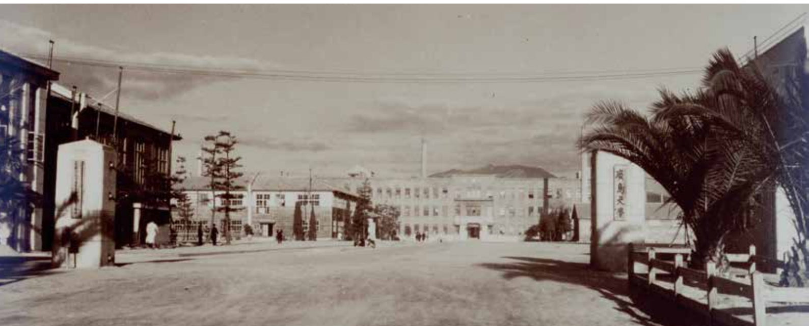
155. 森戸道路〔昭和30年代前半〕 道路は未舗装だった。
