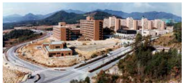
182. 完成間近な生物生産学部〔昭和62年12月〕
