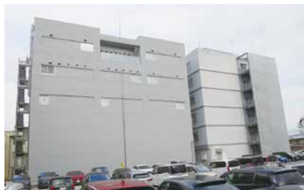
87. 放射線先端医学実験棟 〔令和3年完成〕
