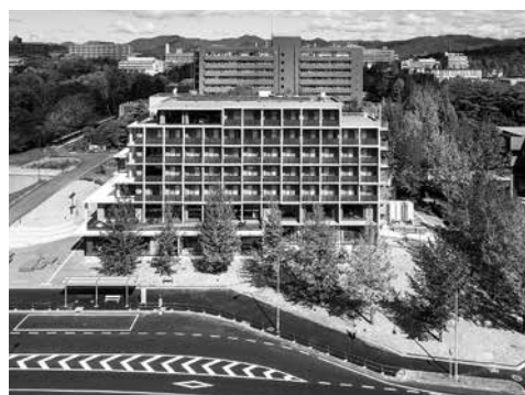
写真6-14 ミライクリエ（令和3年10月完成）
