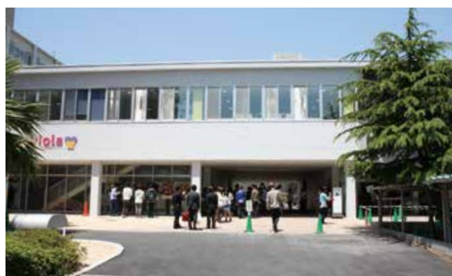
82. 霞会館〔平成26年改修〕 右は食堂の様子。
