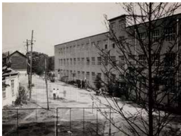
158. 工学部(化学工学棟、応用化学棟) 〔千田、昭和42年前後〕
