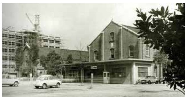
159. 医学部附属病院外来診療棟と建設が進む 歯学部校舎〔霞、昭和42年〕
