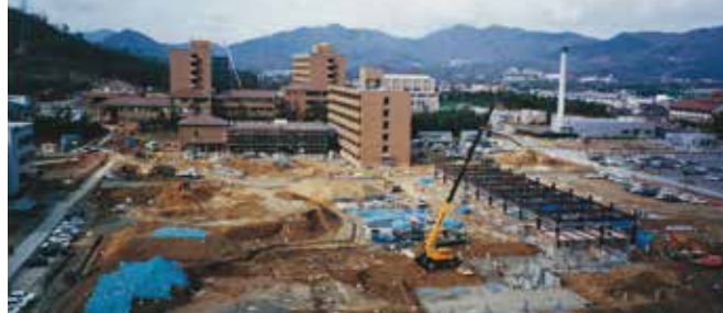
185. 建設工事中の法学部・経済学部 〔平成6年1月〕
