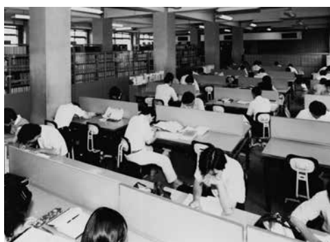
写真7-2 図書館閲覧室（東千田、昭和56年）
