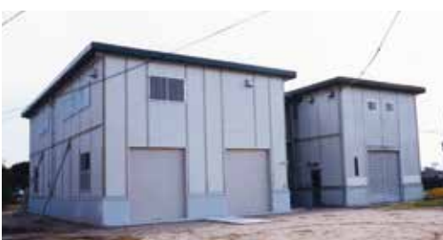
115. 艇庫：体育会ボート部艇庫 〔広島市庚午南、平成14年完成〕
