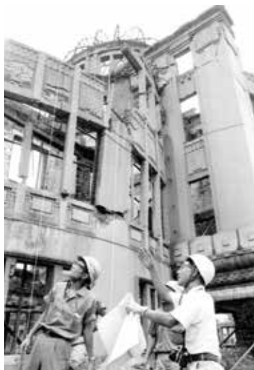
138. 保存工事に向けて原爆ドームを調査する工学部関係者 〔昭和40年7月〕
