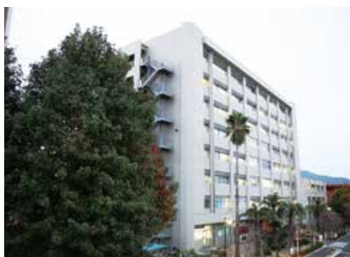
75. 基礎・社会医学棟〔平成19年改修〕
